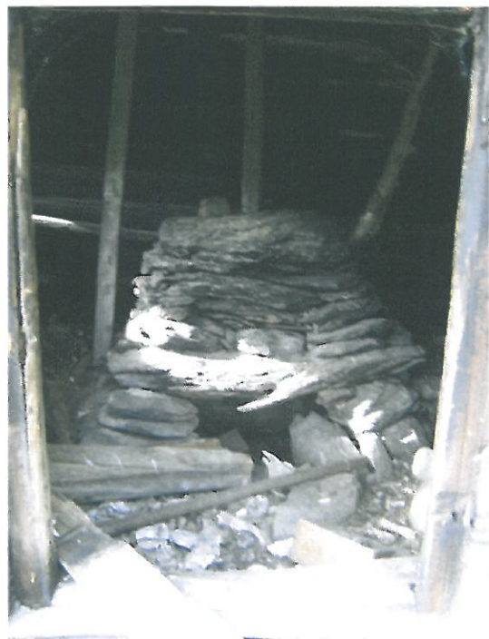
Figur 44. Taket må støttes opp med stokker. Inne i badstua står en røykovn.
