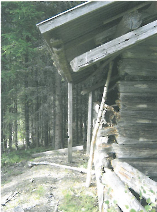
Figur 44. Taket må støttes opp med stokker. Inne i badstua står en røykovn.
