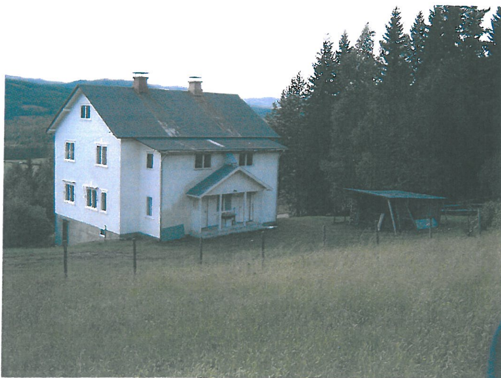
Figur 17. Huset til Anders Bergsrud
