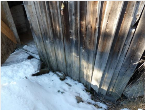
Det er litt råte i nederkant panel på desse to plassane.
