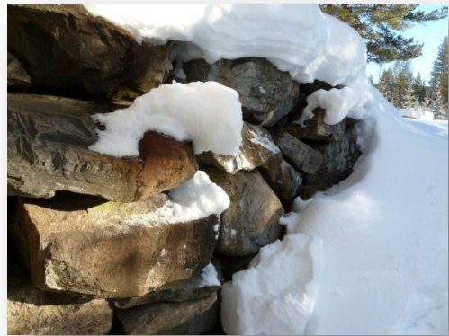
Fundamentet ved døra er i ferd med å gli ut og må stabiliserast.
