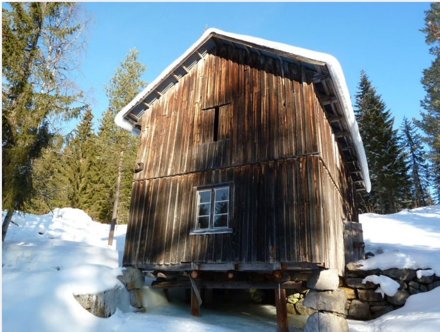
Veggen mot sør.
