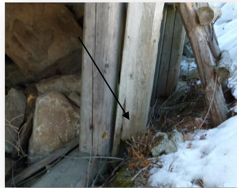
Døra i fyrste høgda har ei kraftig omramming, denne er roten nedst.
