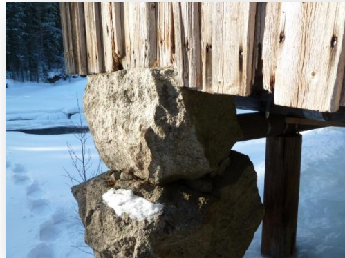
Det er litt råte i nederkant panel på desse to plassane.
