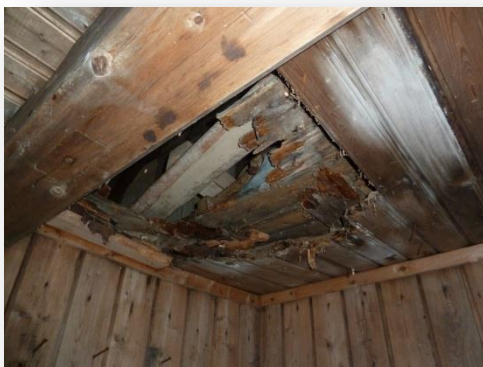
Råte i himling og golv i kvilerommet.
