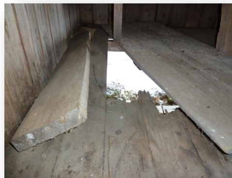
Råte i himling og golv i kvilerommet.
