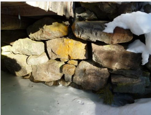
Fundamentet ved døra er i ferd med å gli ut og må stabiliserast.
