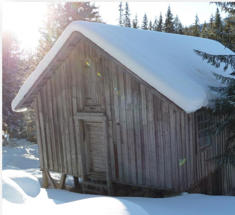
Veggen mot nord.
